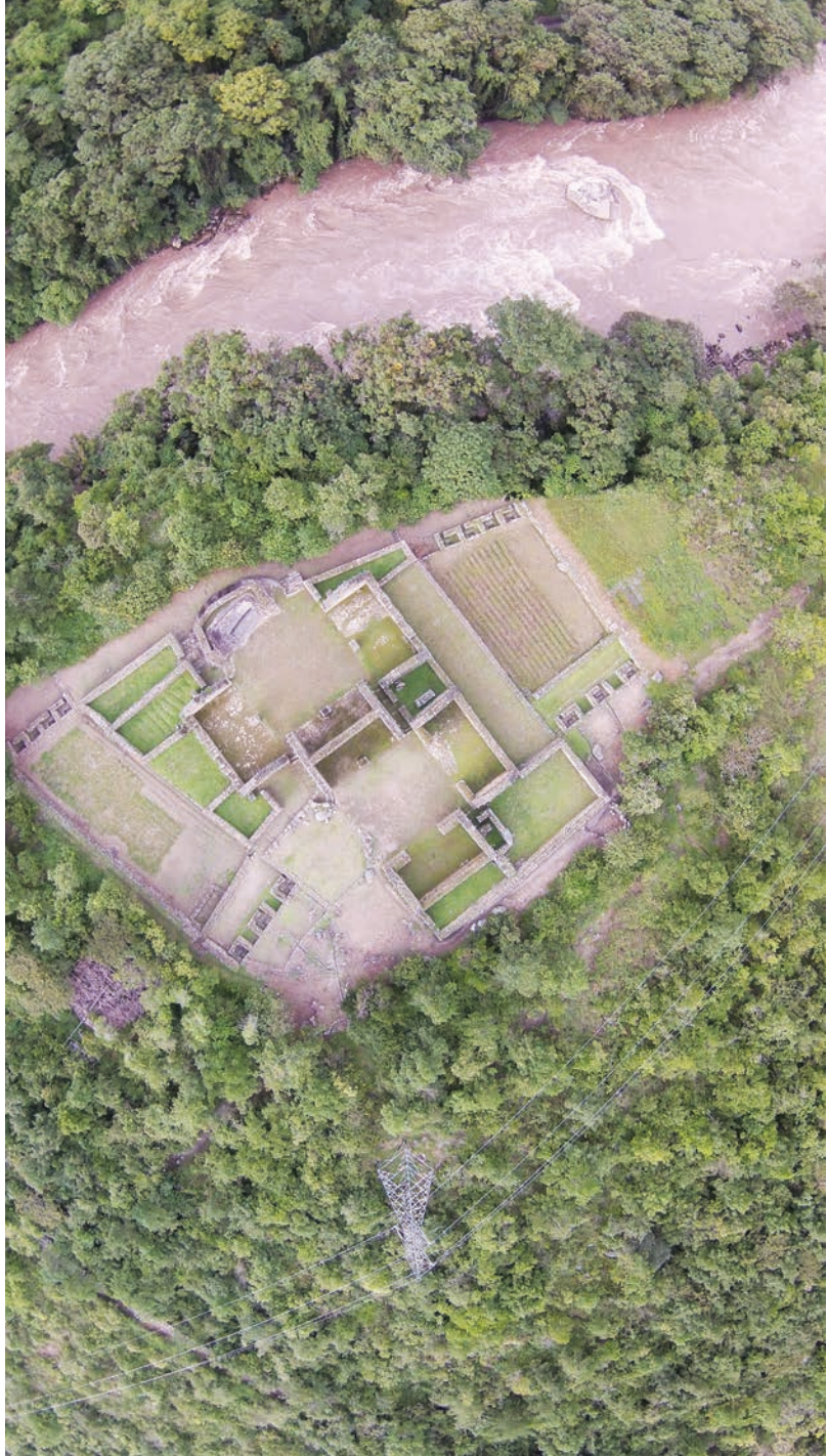
figure 9.7 Drone photography of Chachabamba. Courtesy of the Dirección Desconcentrada de Cultura de Cusco, Ministerio de Cultura, Peru.
